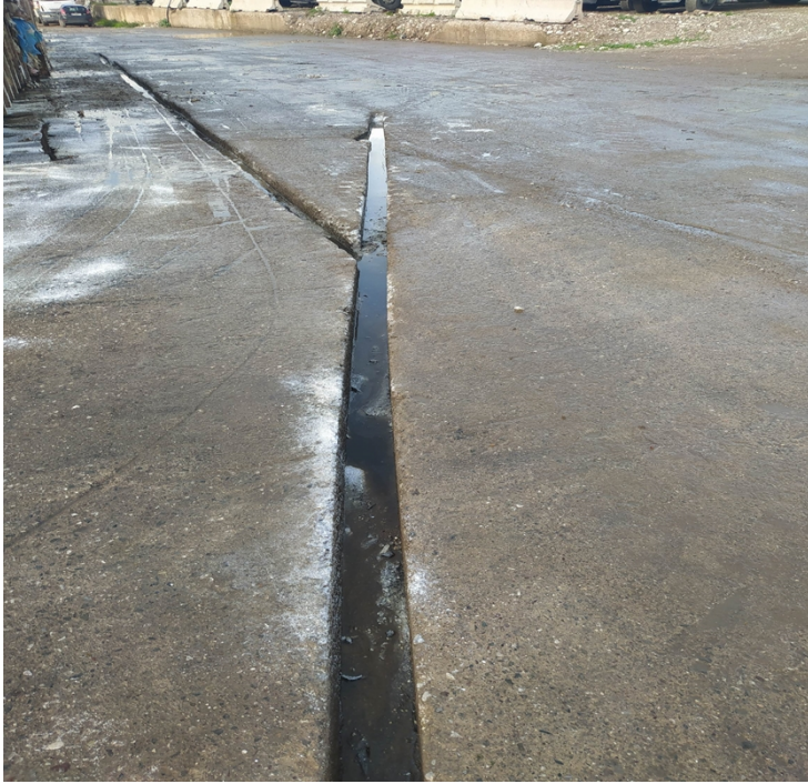
Εικόνες 2 και 3 : Διαμόρφωση επί του τσιμεντένιου δαπέδου (μικρός συλλεκτήριος αγωγός-τάφρος), για την κατάληξη των υγρών αποβλήτων στην υπόγεια στεγανή δεξαμενή συγκέντρωσης
