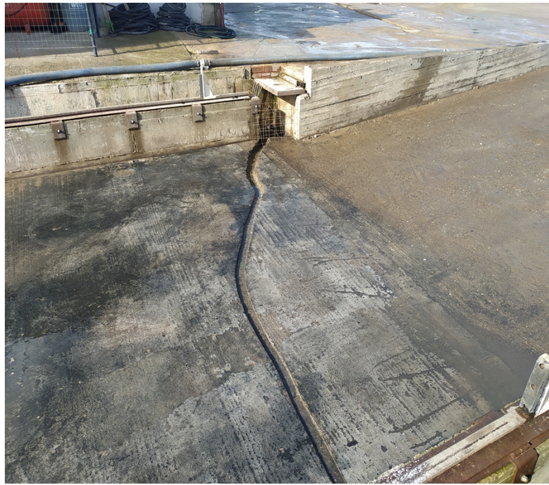
Εικόνες 2 και 3 : Διαμόρφωση επί του τσιμεντένιου δαπέδου (μικρός συλλεκτήριος αγωγός-τάφρος), για την κατάληξη των υγρών αποβλήτων στην υπόγεια στεγανή δεξαμενή συγκέντρωσης
