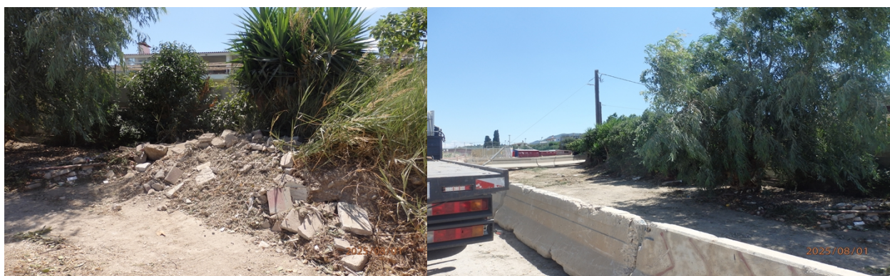
Φωτ1: Απόθεση ΑΕΚΚ στο χώρο
