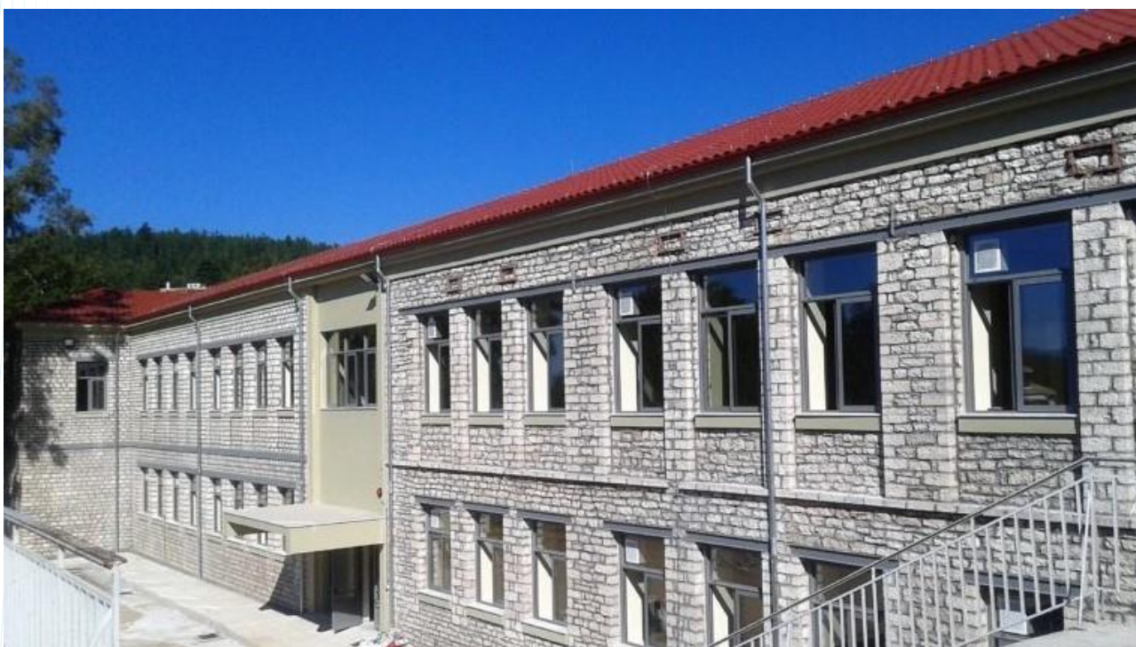
Αποκατάσταση στατικής επάρκειας του γυμνασίου Θέρμου
