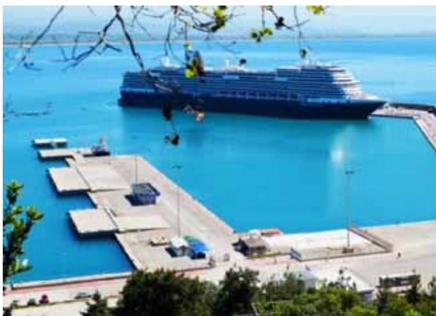
Εκτέλεση Συμπληρωματικών Έργων στον Λιμένα Κατακόλου Α' Υποέργο Επέκταση Παραλιακού Κρηπιδώματος Έμπροσθεν Καταστημάτων
