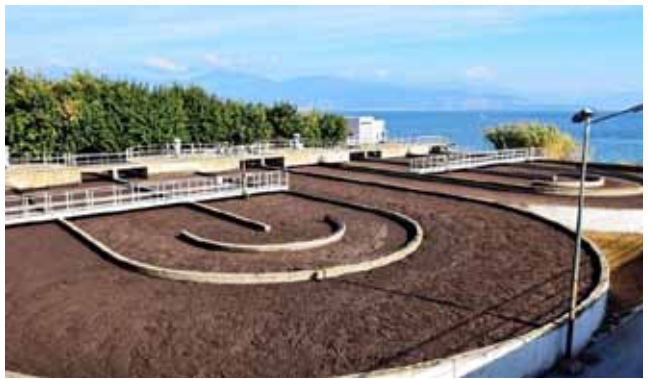
Κατασκευή κεντρικών αποχετευτικών αγωγών παραλιακών οικισμών από Δήμο Ερινεού έως Δήμο Αιγείρας
