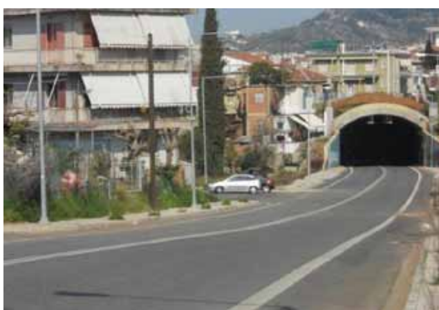
Κατασκευή Περιμετρικής Οδού Αγρινίου – Τμήμα Β-Γ
