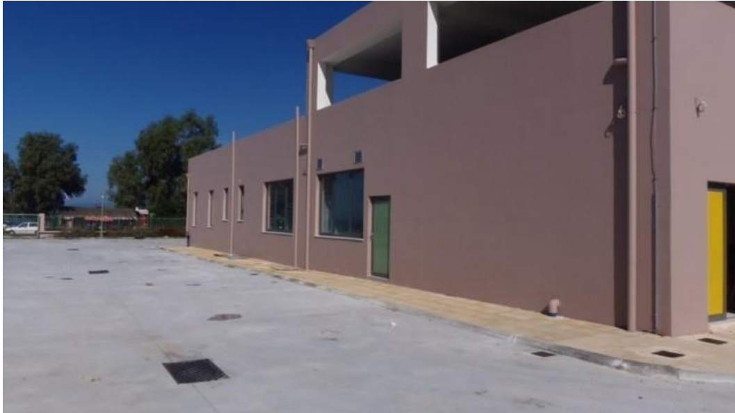
Κατασκευή Νέας Μονάδας Σπαστικών Παίδων-Κέντρο Ημερήσιας Φροντίδας Πατρών
