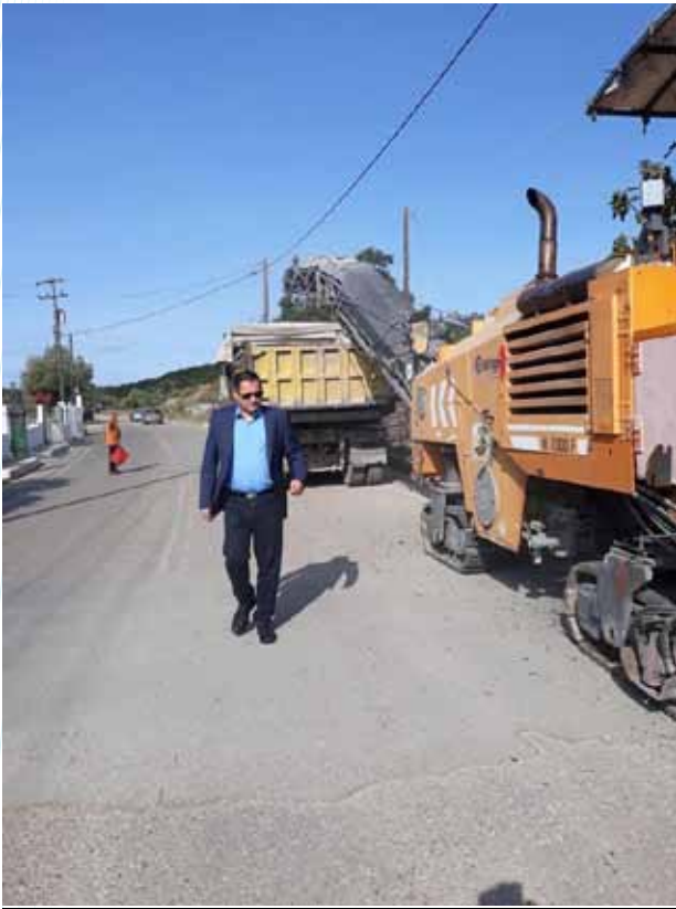
Επίσκεψη Αντιπεριφερειάρχη Αγροτικής Ανάπτυξης κατά την διάρκεια έργων στην επαρχιακή οδό Αμαλιάδα-Γεράκι στην περιοχή οικισμού Γερακίου.
