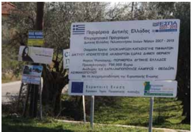
Ολοκλήρωση κατασκευής τμημάτων δικτύου αποχέτευσης ακαθάρτων έδρας Δήμου Θέρμου
