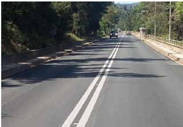
Αναβάθμιση, βελτίωση και συντήρηση της Παλαιάς Εθνικής οδού Κορίνθου – Πατρών στο τμήμα Πάτρα – Αίγιο
