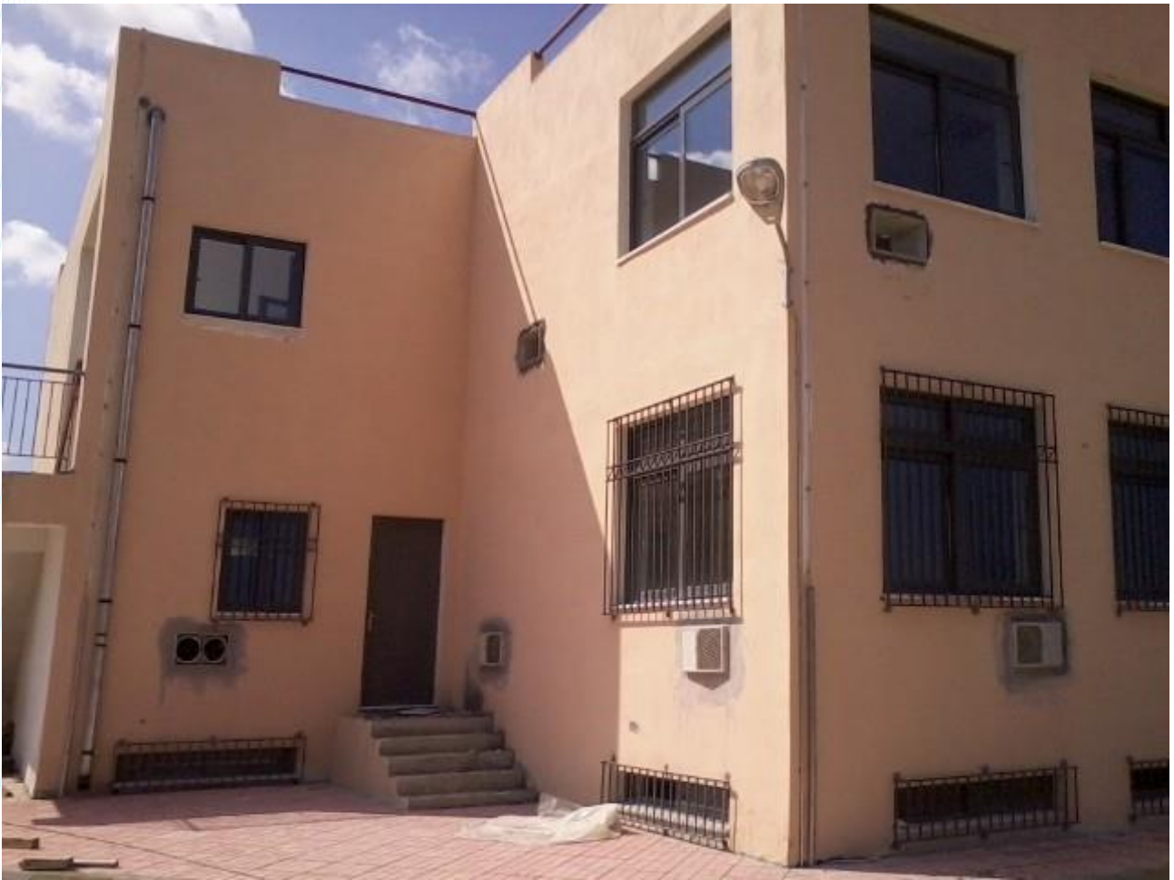
Ανέγερση Σχολικού κτιρίου Γυμνάσιο Λουσικών
