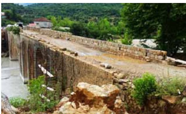
Αποκατάσταση ζημιών των γεφυριών Τέμπλας και Αυλακίου που προκλήθηκαν από θεομηνία τον Ιανουάριο και Φεβρουάριο 2015
