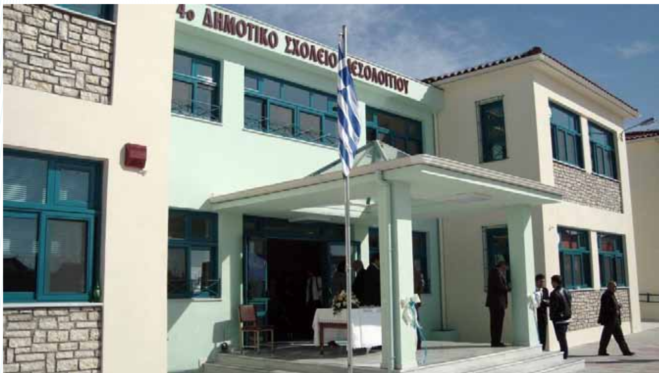
Ανέγερση 4ου Δημοτικού Σχολείου Μεσολογγίου
