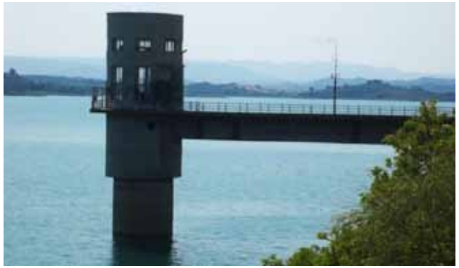
Επισκευή – Αποκατάσταση Λειτουργίας ηλεκτρομηχανολογικού εξοπλισμού φράγματος Πηνειού Π.Ε. Ηλείας
