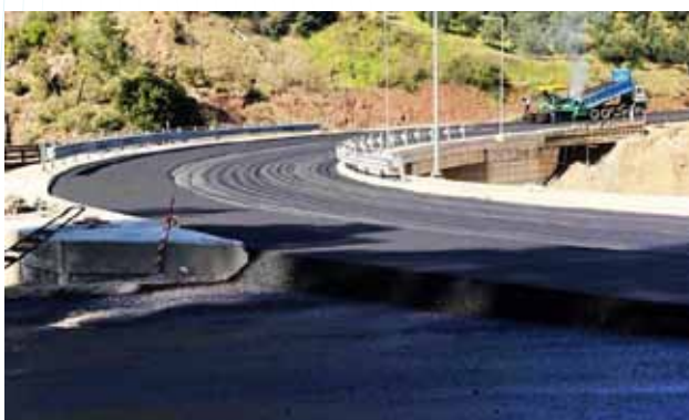
Βελτίωση επαρχιακής οδού Κρέστενα _ Ανδρίτσαινα - _Επικούριος Απόλλωνας Τμήμα Διάσελλα _Μπαρακίτικα
