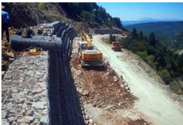
Έργο αποκατάστασης ζημιών και βατότητας της 15ης Επαρχιακής οδού στη Θέση Καστανόρεμα
