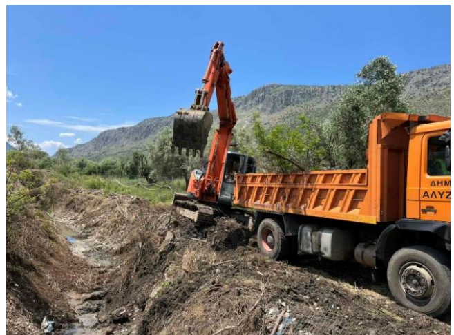
Έργα αντιπλημμυρικής θωράκισης στην Κανδήλα Αιτ/νιας.
