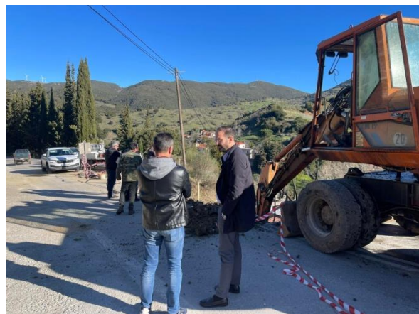
Κομπηγάδι-Λακκώματα-ΠΕ Αχαΐας: Εργασίες για την αποκατάσταση της βατότητας.
