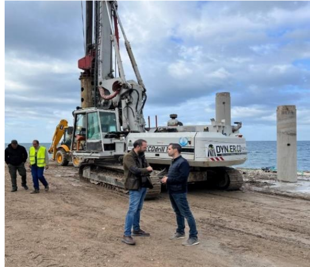
Τον Νοέμβριο του 2024 ξεκίνησαν οι εργασίες αποκατάστασης στην παράκτια ζώνη Ρίου - Αγίου Βασιλείου με εξασφαλισμένη χρηματοδότηση 9.65 εκ. €
