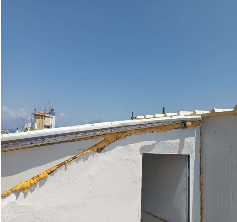
Εικόνες 3 και 4 : Δώμα που έλαβε χώρα η αποξήλωση των στοιχείων αμιάντου και η αντικατάστασή τους με πάνελ πολυουρεθάνης
