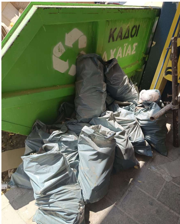
Εικόνες 1 και 2 : Σακούλες που περιέχουν κομμάτια από δομικά στοιχεία αποξηλωμένου ελενίτ, έμπροσθεν του ακινήτου
