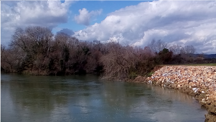
Φωτ.5.1: ΘΕΣΗ 5 (Γουριά, ανάντη του κατασκευασμένου μανδύα)
