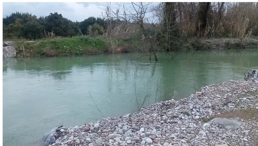
Φωτ.1.3: ΘΕΣΗ 1Α-1Β (Βόρεια ΒΙΟ.Κ.Α., υφιστάμενη τάφρος)
