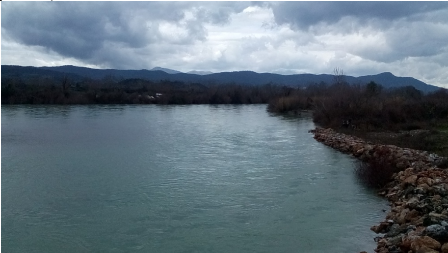
Φωτ.3.1: ΘΕΣΗ 3 (Αγγελόκαστρο, τμήμα του κατασκευασμένου μανδύα)
