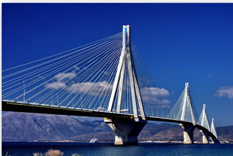
Η γέφυρα Ρίου – Αντιρρίου
