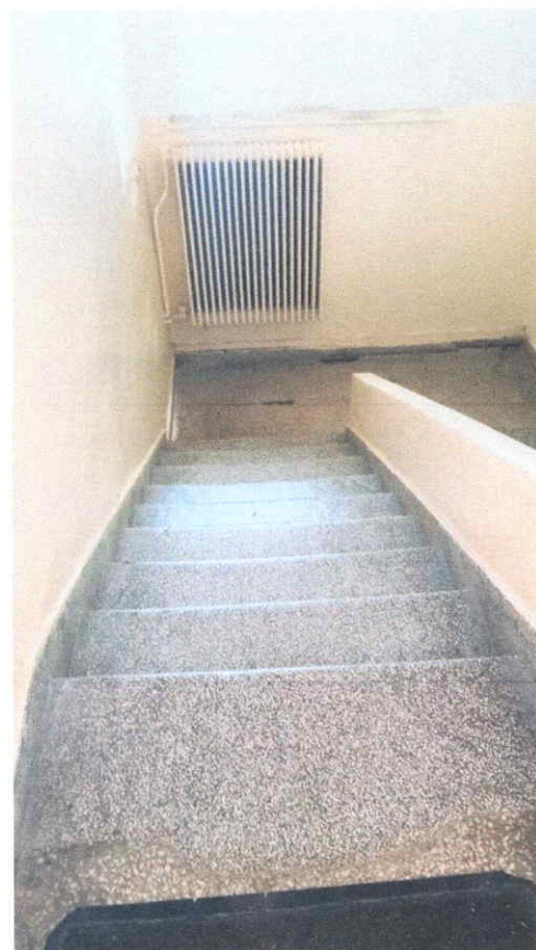
ΦΩΤ.8 ΒΟΗΘΗΤΙΚΟ ΚΛΙΜΑΚΟΣΤΑΣΙΟ
