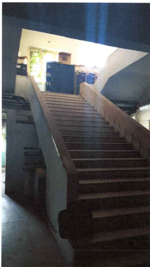
ΦΩΤ.5 ΚΥΡΙΟ ΚΛΙΜΑΚΟΣΤΑΣΙΟ
