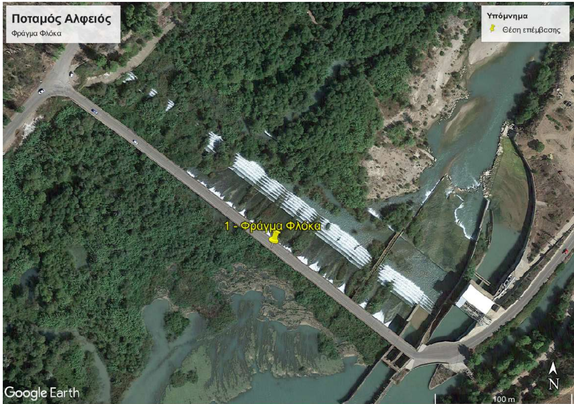
Εικ.2 : Απόσπασμα δορυφορικής εικόνας Google-Earth με τη θέση της επέμβασης στο Φράγμα Φλόκα (θέση1)
