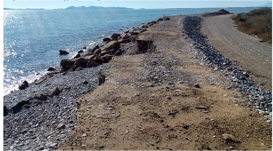
Φωτ.7: ΘΕΣΗ 6 (Υπολείμματα λιθορριπής προστασίας του παράκτιου αναχώματος)
