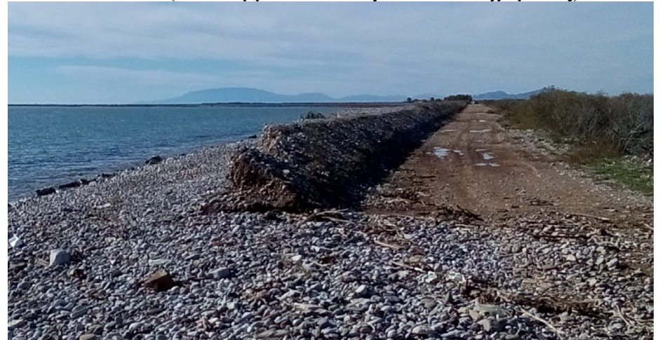
Φωτ.8: ΘΕΣΗ 6 (Υπολείμματα του παράκτιου αναχώματος)
