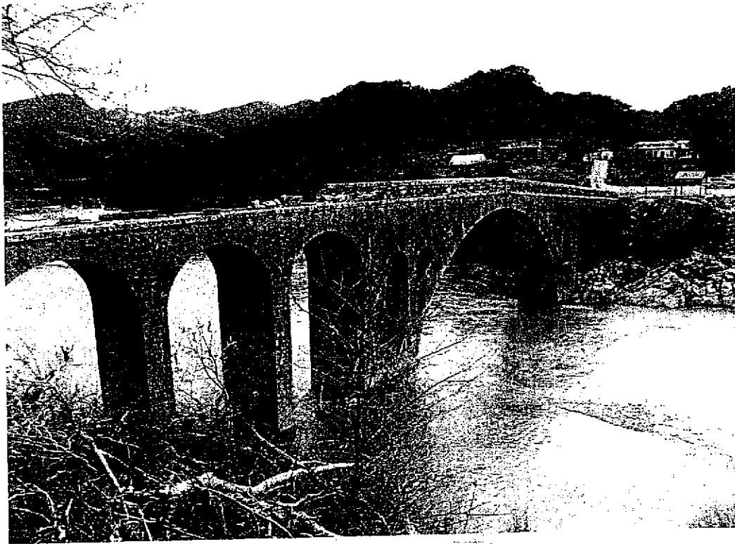
Γέφυρα Αυλακίου. Γενική Άποψη από δυτικά. Διακρίνεται η καταστροφή στο στηθαίο στην βορεινή πλευρά της γέφυρας.
