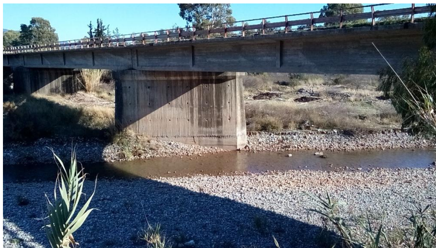
Φωτ.2: ΘΕΣΗ 2 (γέφυρα Μόρνου)
