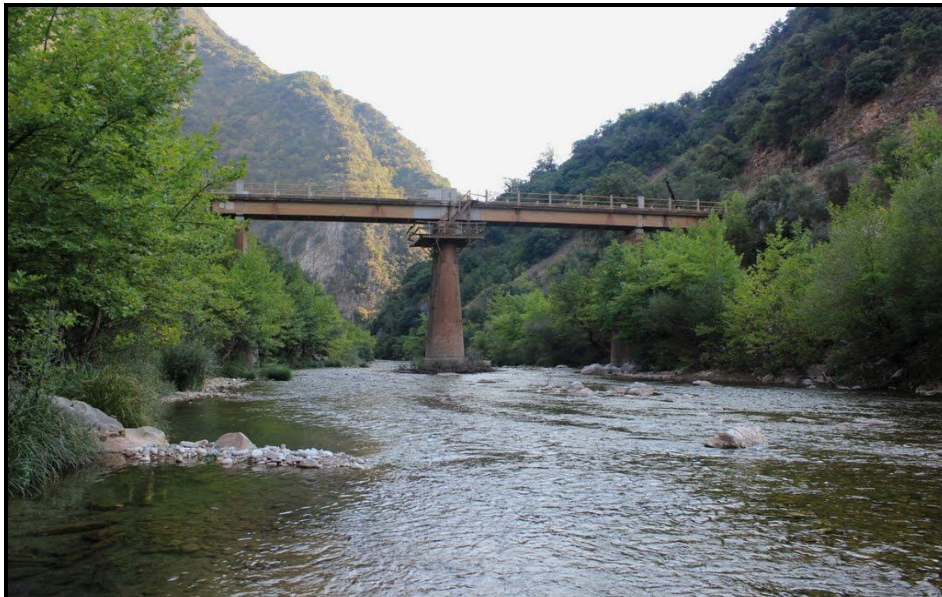
Εικ. 3: Άποψη της γέφυρας από ανάντη
