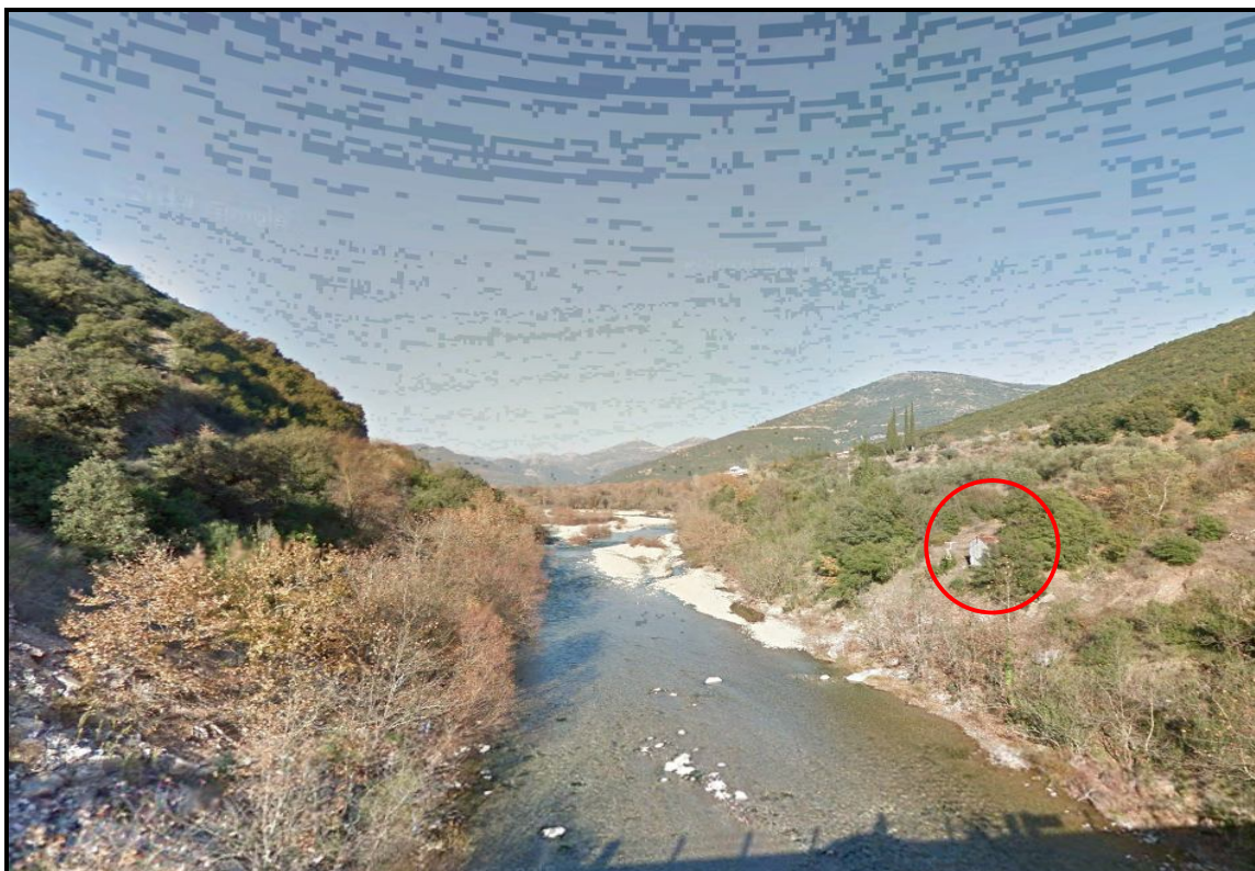
Εικ. 18: Άποψη της κοίτης από ανάντη. Διακρίνεται ο υδρομετρικός σταθμός με τα καλώδια ανάρτησης.
