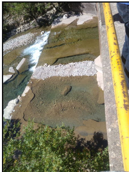
Εικ. 6: Υποσκαφή (προ των εργασιών). Άποψη από το επίπεδο του καταστρώματος.
