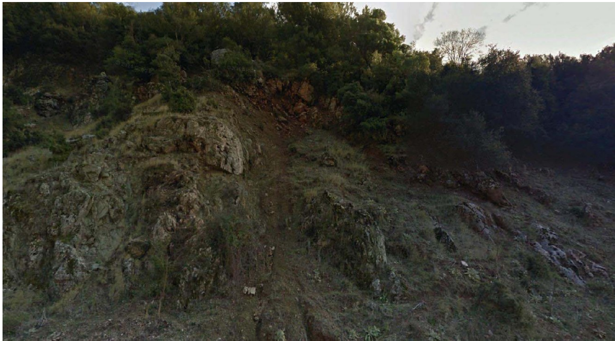
Φωτ 5 : Το άνω σημείο της φωτ 3 :Κατακερματισμένο βραχώδες πρανές σε συνδυασμό με αποσαθρωμένο μανδύα
