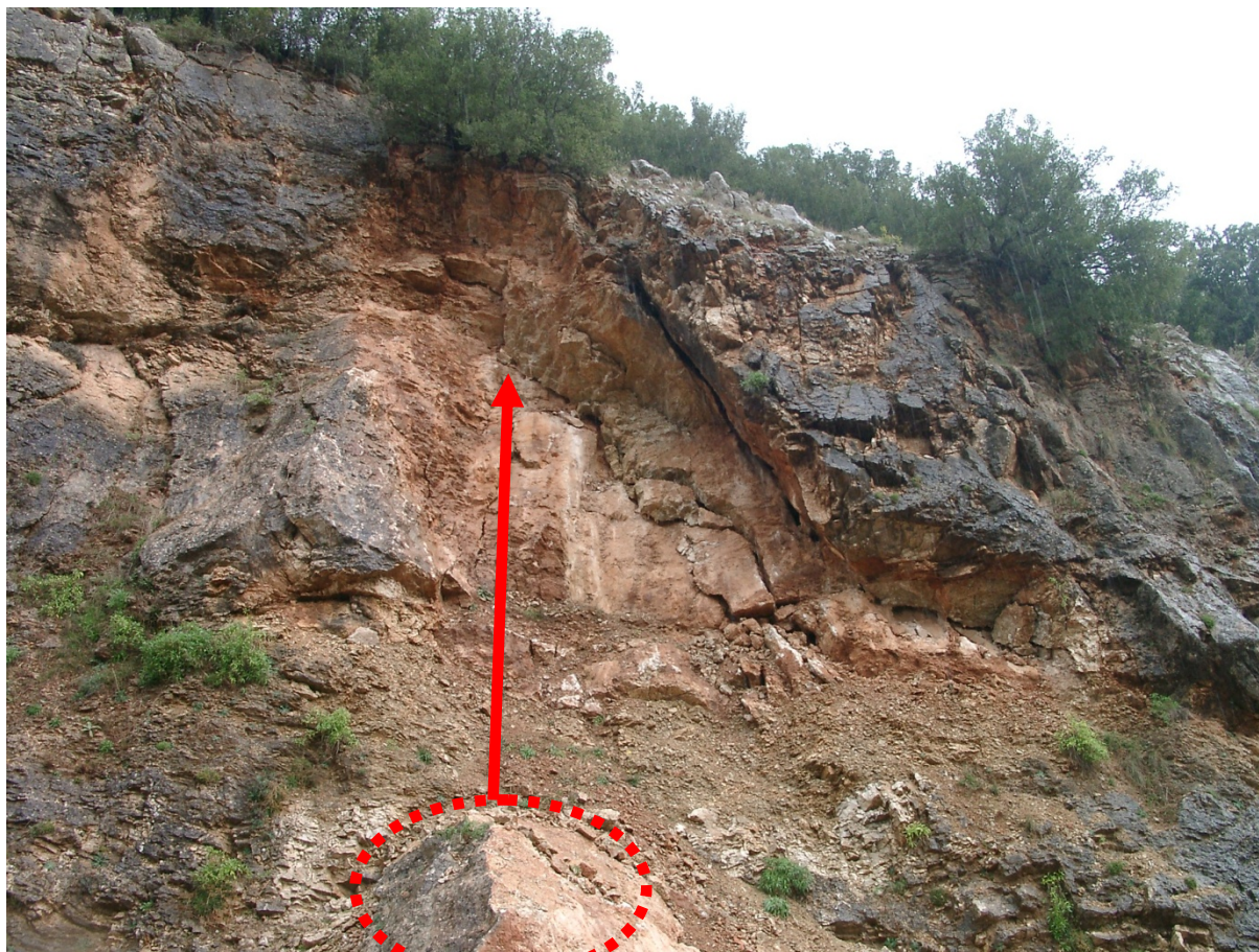
ΦΩΤ 8: Έντονα κερματισμένοι ασβεστόλιθοι (Θέση Θεόκτιστο). Φωτό μετά την πτώση ενός ασβεστολιθικού τεμάχους στις παρυφές του οδοστρώματος
