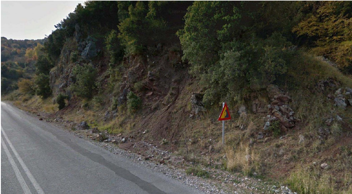
Φωτ 1: Θέση Λαμπερία_1 στην ΧΘ : 75.600 :Κατακερματισμένο βραχώδες πρανές σε συνδυασμό με αποσαρθρωμένο μανδύα
