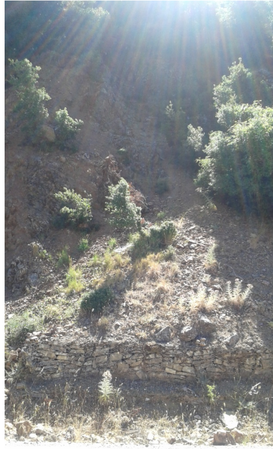
Φωτ 4 : Θέση Λαμπεία_2. Κατακερματισμένο βραχώδες πρανές σε συνδυασμό με αποσαθρωμένο μανδύα
