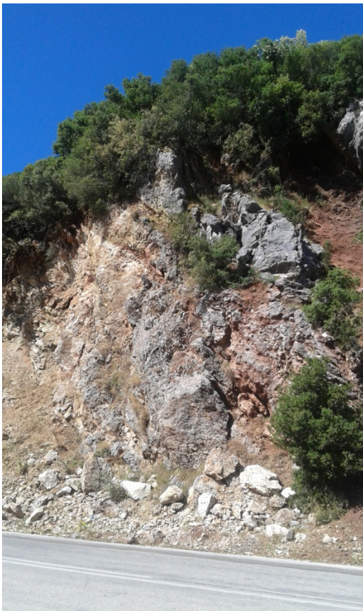
Φωτ 2: Κατακερματισμένο βραχώδες πρανές σε συνδιασμό με αποσαθρωμένο μανδύα
