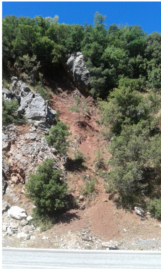
Φωτ 2: Κατακερματισμένο βραχώδες πρανές σε συνδιασμό με αποσαθρωμένο μανδύα
