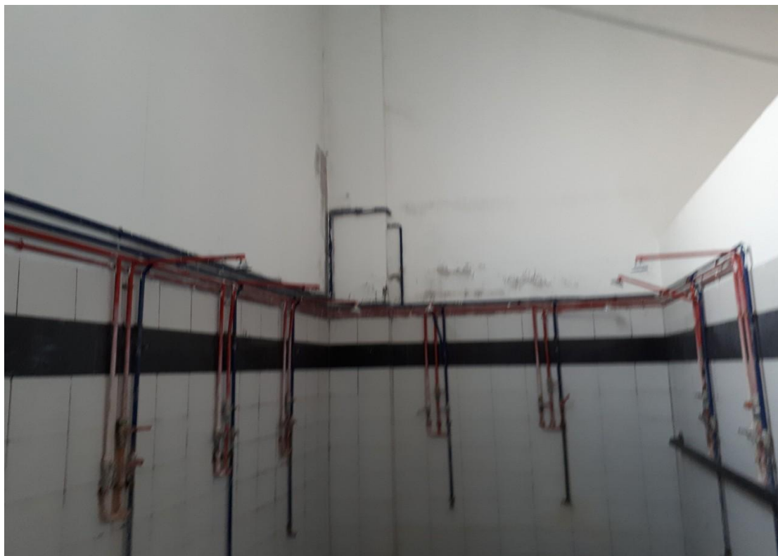
ΥΦΙΣΤΑΜΕΝΗ ΚΑΤΑΣΤΑΣΗ ΕΣΩΤΕΡΙΚΩΝ ΤΟΙΧΩΝ ΓΗΠΕΔΟΥ
