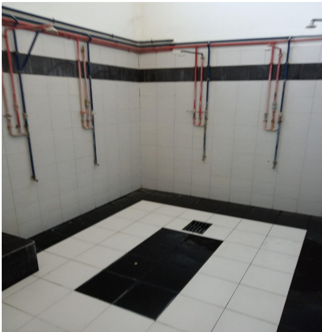
ΥΦΙΣΤΑΜΕΝΗ ΚΑΤΑΣΤΑΣΗ ΑΠΟΔΥΤΗΡΙΩΝ - ΧΩΡΟΣ ΝΤΟΥΣ
