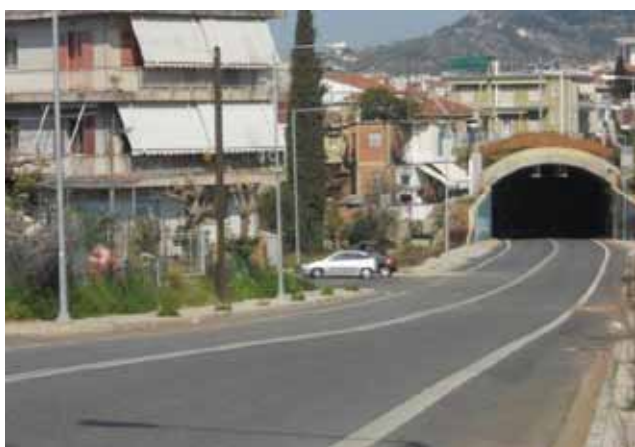
Κατασκευή Περιμετρικής Οδού Αγρινίου – Τμήμα Β-Γ
