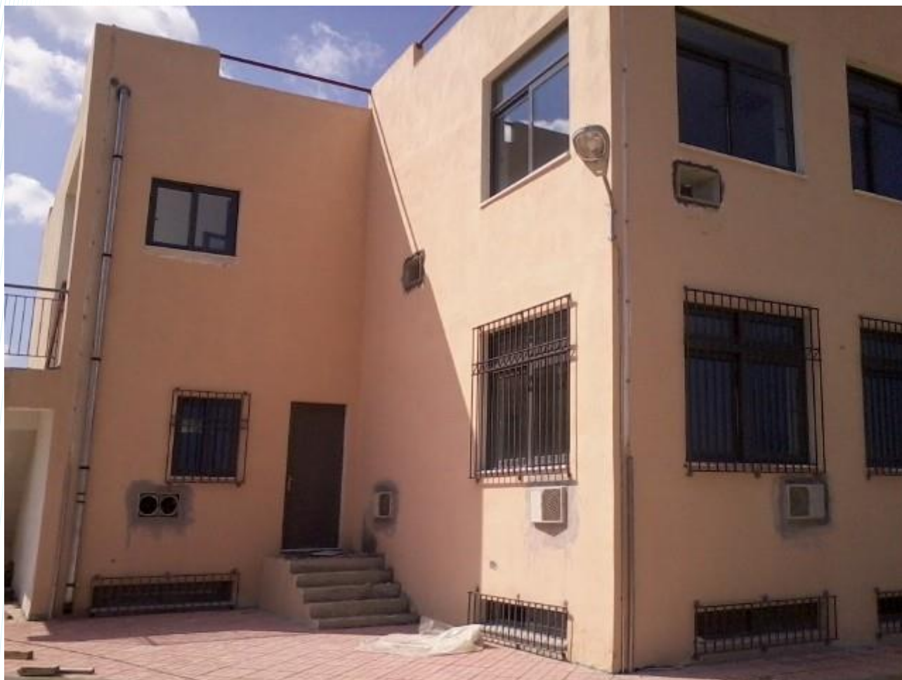
Ανέγερση Σχολικού κτιρίου Γυμνάσιο Λουσικών
