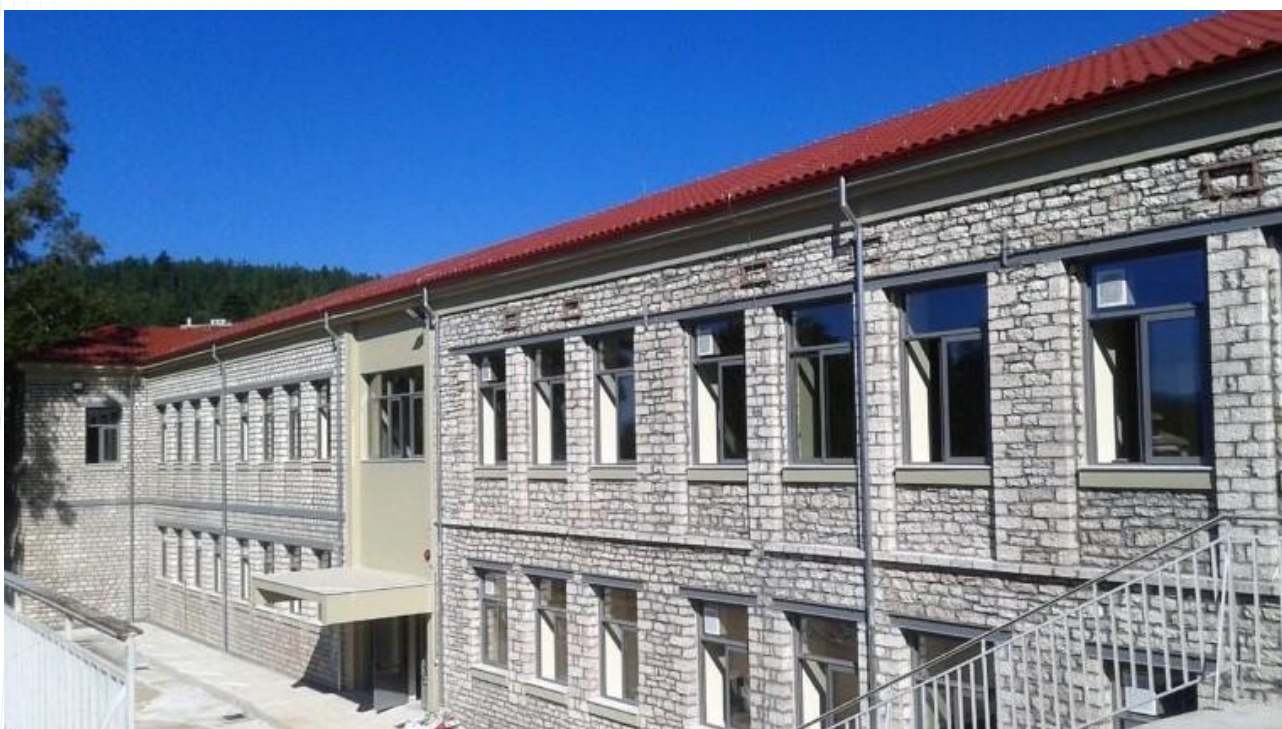
Αποκατάσταση στατικής επάρκειας του γυμνασίου Θέρμου
