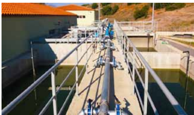
Αποχέτευση και επεξεργασία Λυμάτων Δήμου Καλαβρύτων
