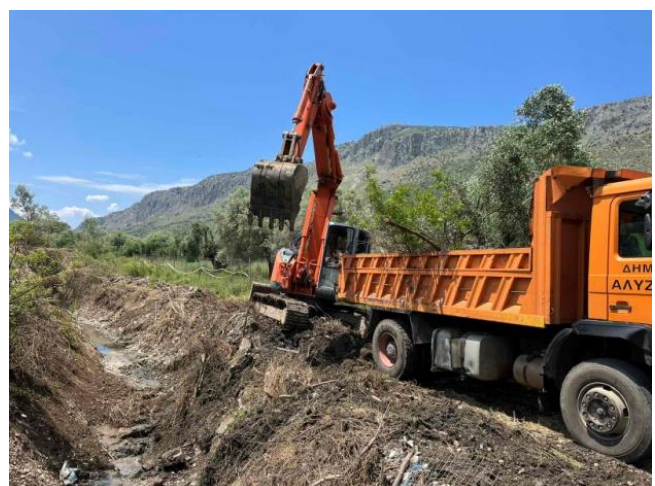
Έργα αντιπλημμυρικής θωράκισης στην Κανδήλα Αιτ/νιας.
