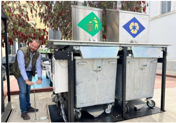
Δράσεις αναζωογόνησης και περιβαλλοντικής ευαισθητοποίησης από την ΠΔΕ με υπογειοποιημένη γωνιά ανακύκλωσης - συμπίεσης στην κεντρική πλατεία Πύργου.
