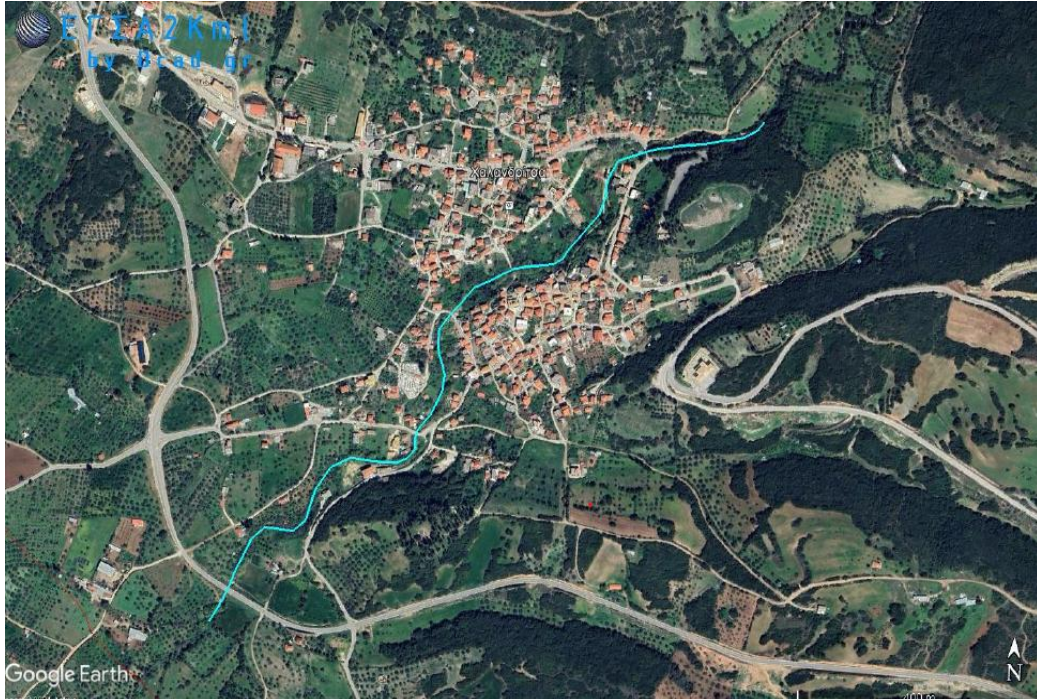
Εικόνα 1 : Περιοχή μελέτης ρέματος Αγ. Ανδρέα εντός οικισμού Χαλανδρίτσας
