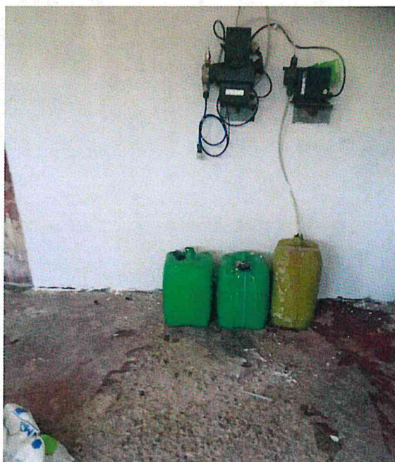
Φωτό 1: Υφιστάμενη και εφεδρική δοσομετρική αντλία.
