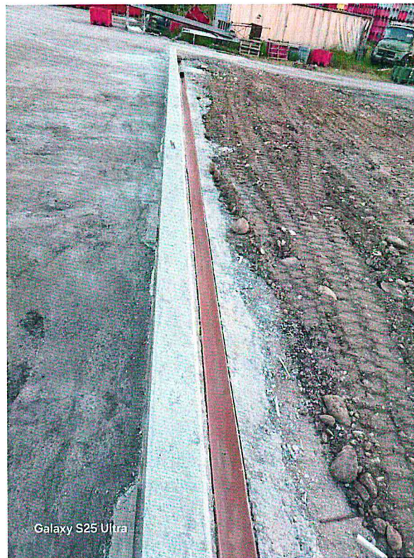
Φωτό 2, 3 : Υπαίθρια στεγανοποιημένη επιφάνεια προσωρινής απόθεσης ξυλώδους μίσχου/"τσίγγανων". Διακρίνεται το κανάλι συλλογής στραγγισμάτων.
