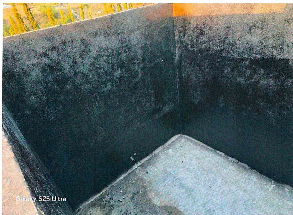
Φωτό 7 : Λεπτομέρειες από την κατασκευή και στεγανοποίηση της δεξαμενής αποθήκευσης υγρών αποβλήτων.
